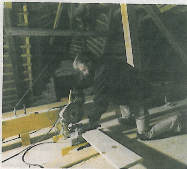
Tømrersvend Simon Sjøgaard er begejstret for opgaven. Det er nemlig rigtigt tømrerarbejde, siger han.
