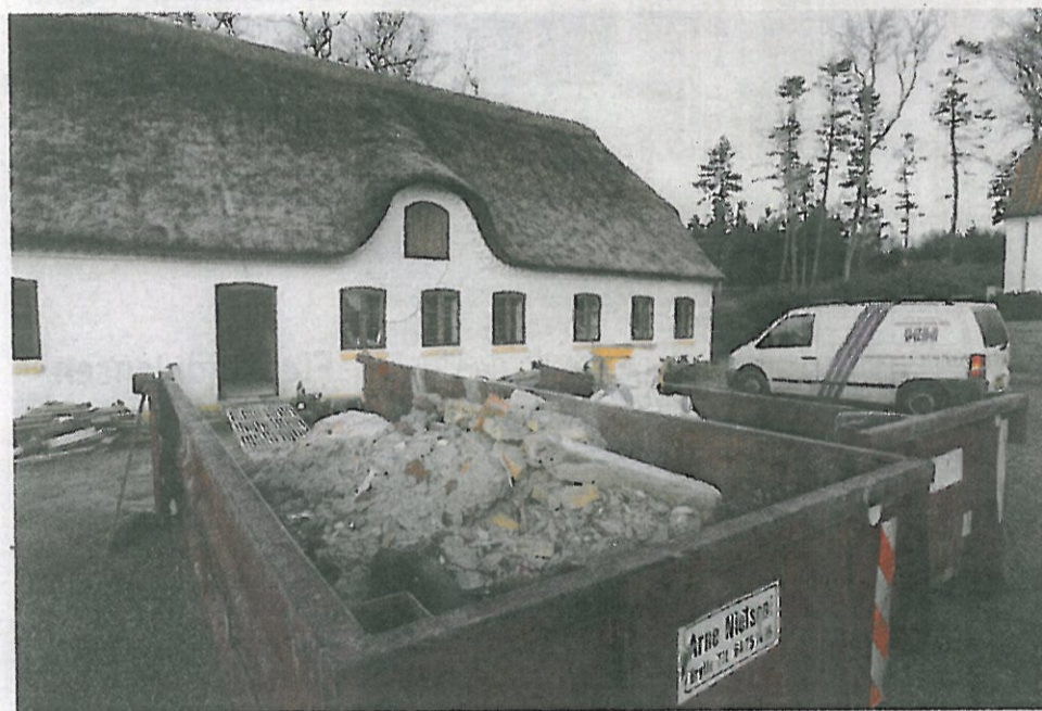
Konfirmandstuen har undergået store forandringer. Bl.a. er det gamle gulv brækket op og erstattet med et nyt, hvor der er indlagt gulvvarme.
